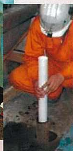
観測井戸設置
