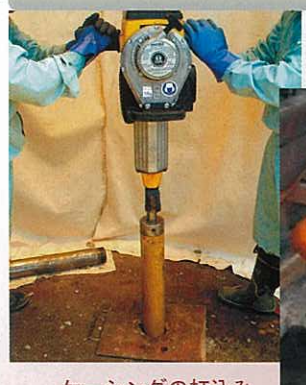
ケーシングの打込み
