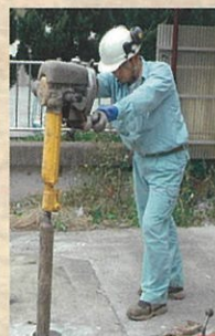
SCSC 式簡易ボーリング
